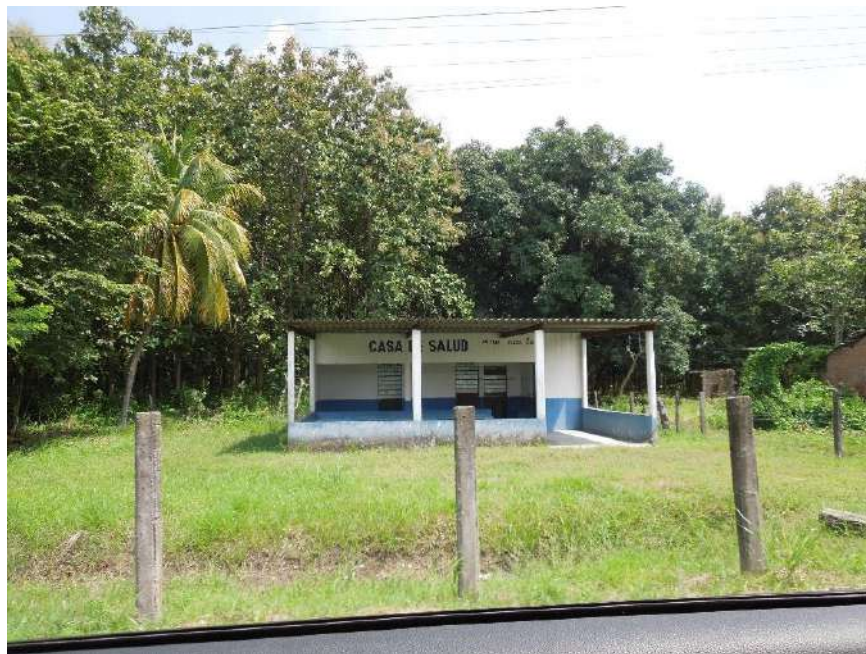
Fig. 70. Casa de SALUD abandonada en Huimanguillo
