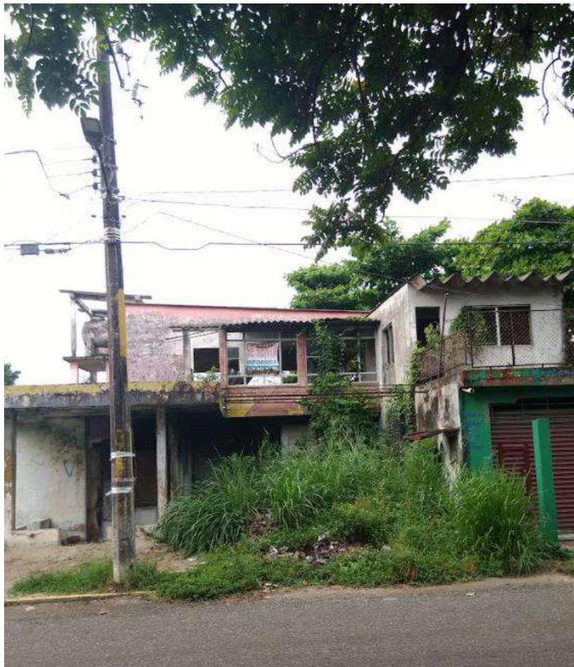
Fig. 124. Vivienda abandonada en la Colonia Electricistas
